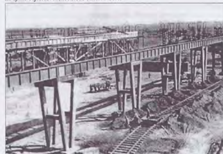
Az épülő szállási tuskóntóde vázzerkezete
