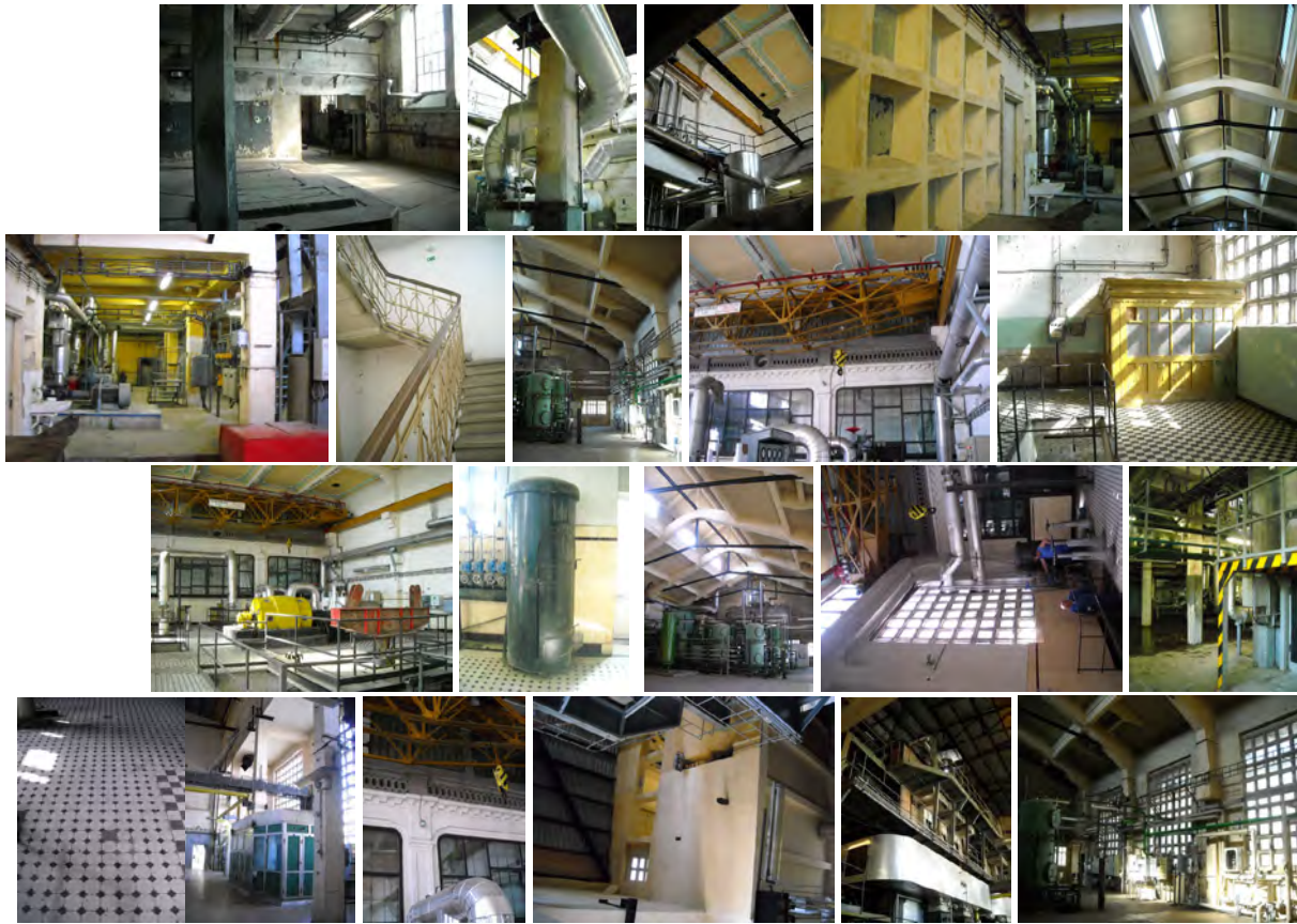
Erőmű nagycsarnok belső terei
