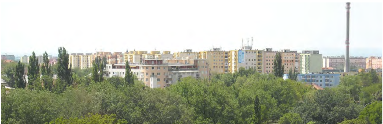
Kikindai úti nővérszálló 10. emeletéről, 2010
